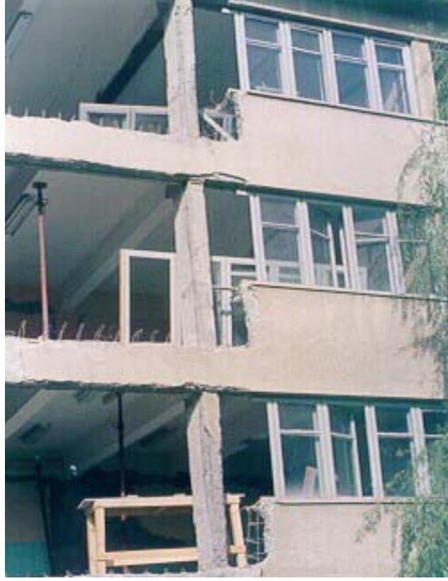
Şekil 9. Erzincan Kazım Karabekir Lisesinde Kolonlar
