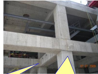
Kuşatılmamış kolon-kiriş birleşim noktası
