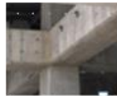
Kuşatılmış kolon-kiriş birleşim noktası
